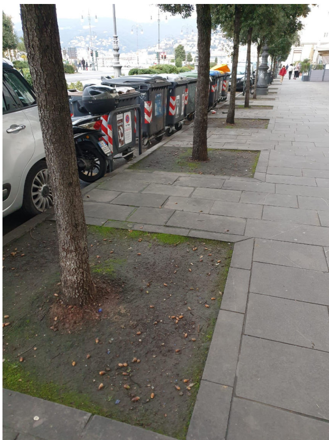
Fig 1b) situazione dei tornelli alla base delle alberature sulle Rive precedentemente all'intervento
